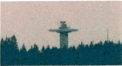
oben: Radarturm nördlich von Lüdenscheid
